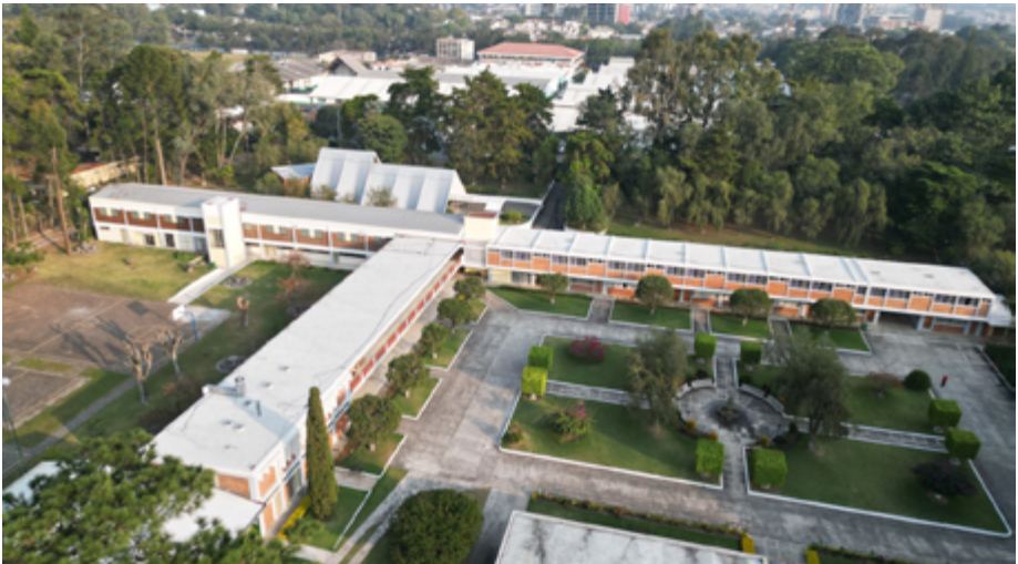
Casa Provincial, Residencia Champagnat y Centro de Formación marista en el terreno de la zona 11, de Guatemala.
