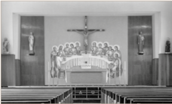
Capilla de Miranda, construida con motivo de la ampliación de la casa para Escolasticado.
