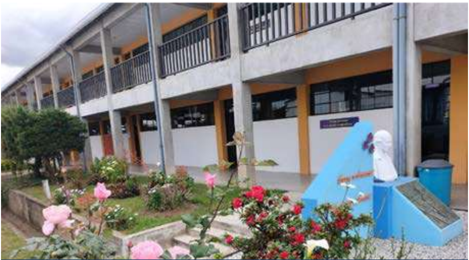
Vista de uno de los pabellones del Instituto Técnico.
